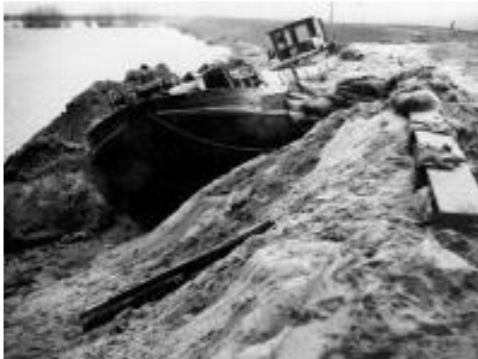
Figuur 5.14 Cruciale sluiting van een bres, nog voor deze echt kon groeien (schip de Twee Gebroeders vaart in een bres in 1953 bij Nieuwerkerk aan de IJssel).
