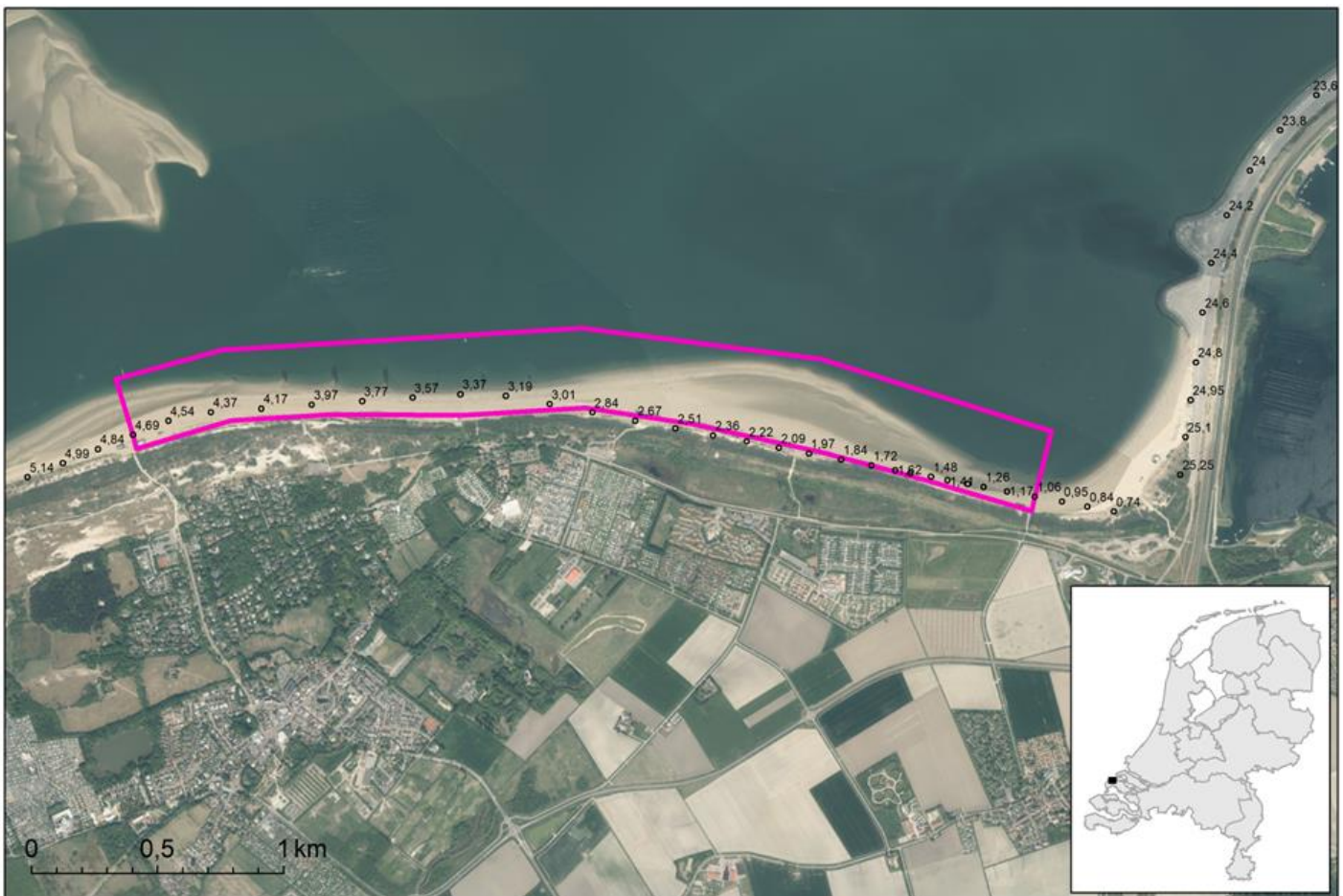
Figuur 4-1 Luchtfoto van de suppletielocatie uit 2022. De roze polygoon toont de raabegrenzing van het suppletievak inclusief uitloopraaien.
