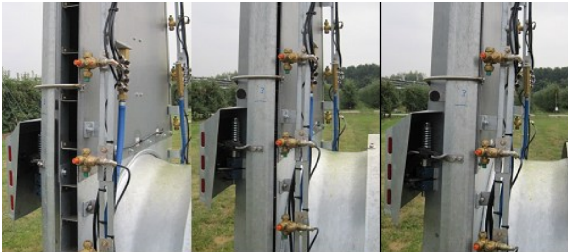
Figuur 4 Klepstanden van het Air Closing System bij de luchtklepinstelling OPEN (links), 80% DICHT (midden) en DICHT (rechts).
