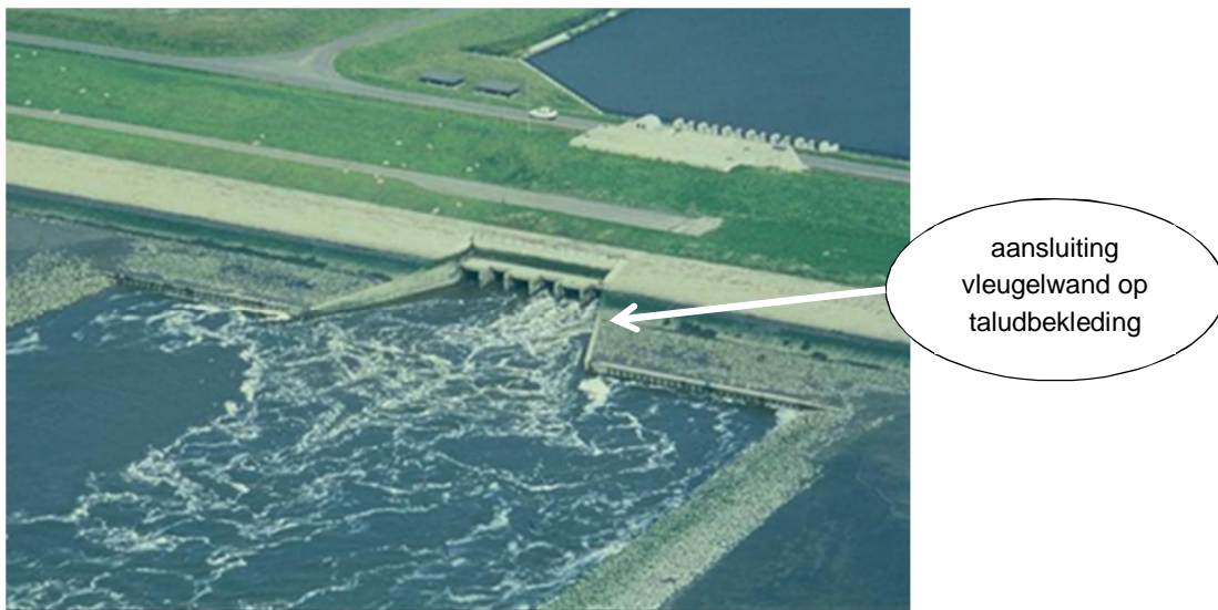
Figuur 2-12: Voorbeeld van aansluiting vleugelwand op taludbekleding (#51), foto van spuisluis bij Bath (bron: Beeldbank Rijkswaterstaat, www.beeldbank.rws.nl )
