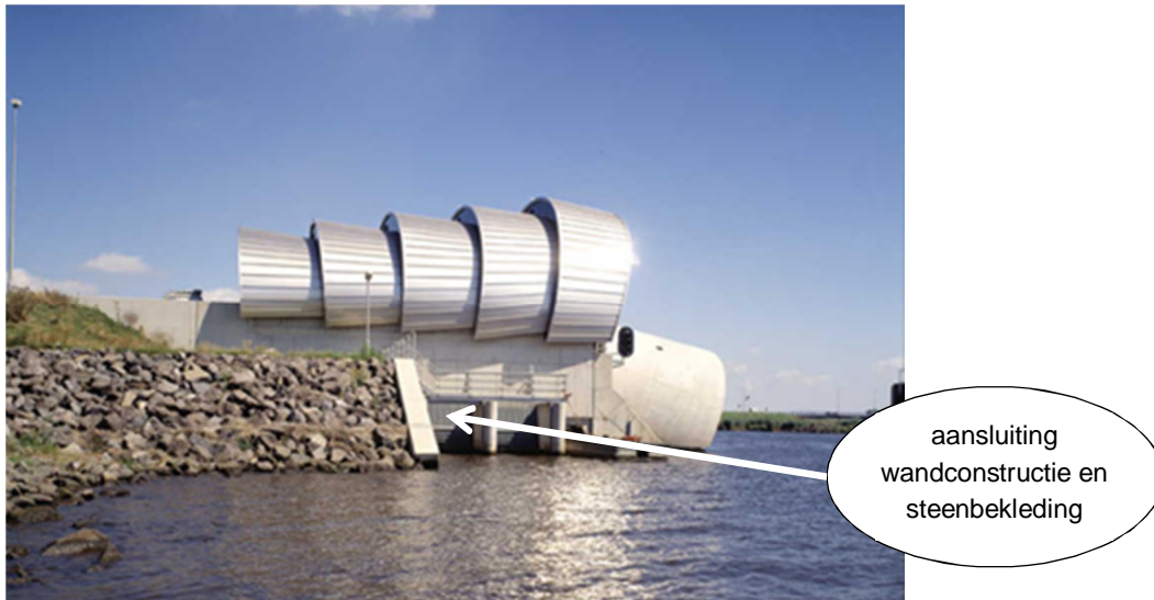
Figuur 2-11: Voorbeeld van aansluiting wandconstructie op steenbekleding (#7), foto van opblaasbare waterkering Ramspol (bron: Zwarts en Jansma Architects, www.zja.nl )
