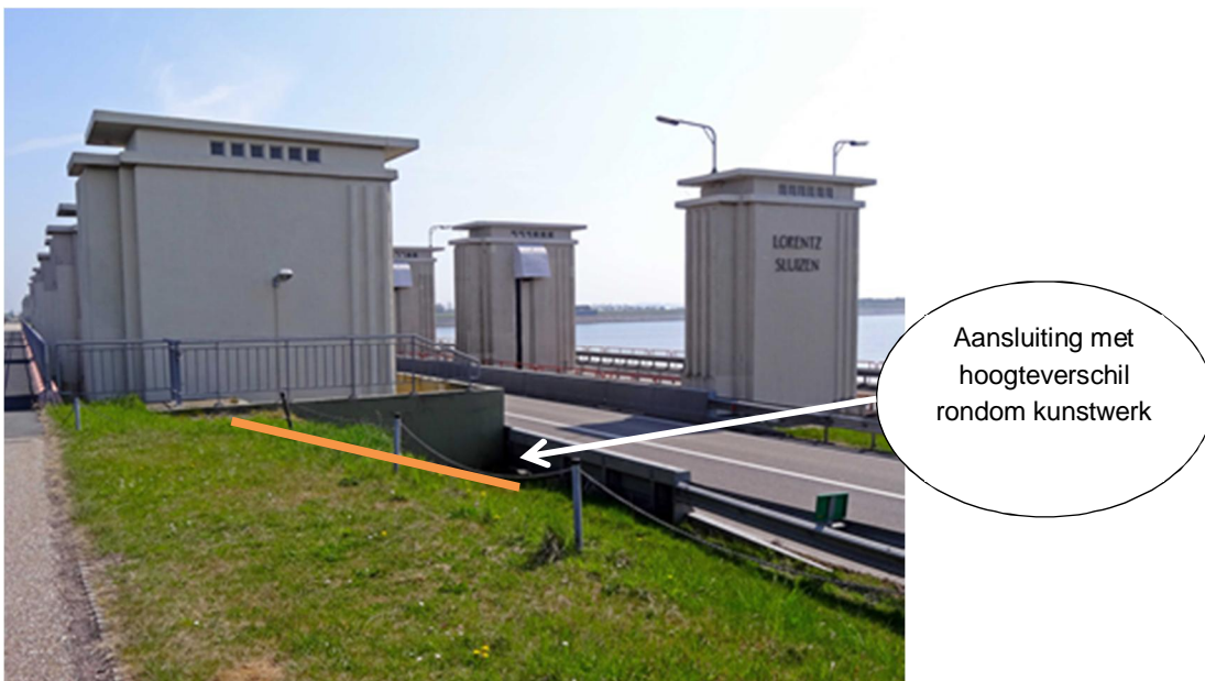
Figuur 2-9: Voorbeeld van aansluiting (met hoogteverschil) rondom kunstwerk (#36), foto van Lorentzsluizen in de Afsluitdijk (bron: Wikimedia Commons)
