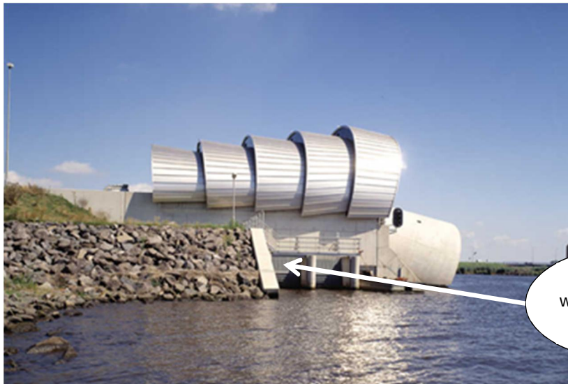
Figuur 2-11: Voorbeeld van aansluiting wandconstructie op steenbekleding (#7), foto van opblaasbare waterkering Ramspol (bron: Zwarts en Jansma Architects, www.zja.nl )
