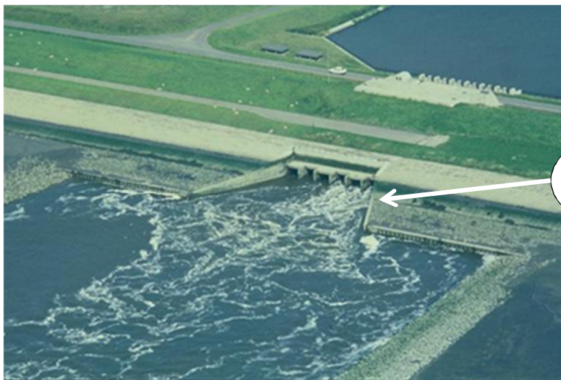
Figuur 2-12: Voorbeeld van aansluiting vleugelwand op taludbekleding (#51), foto van spuisluis bij Bath (bron: Beeldbank Rijkswaterstaat, www.beeldbank.rws.nl )
