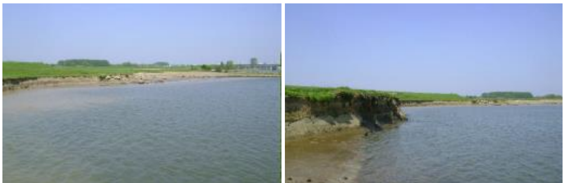
Figuur 8.2 Foto-impressie van het projectgebied, juni 2016: steile oever door erosie
