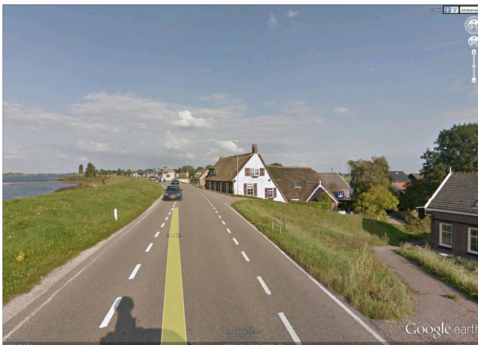
Figuur 6.11 Streetview-beeld richting het oosten. Binnendijs is er veel bebouwing tegen en op de dijk, buitendijs is ter plaatse geen uiterwaard aanwezig.
