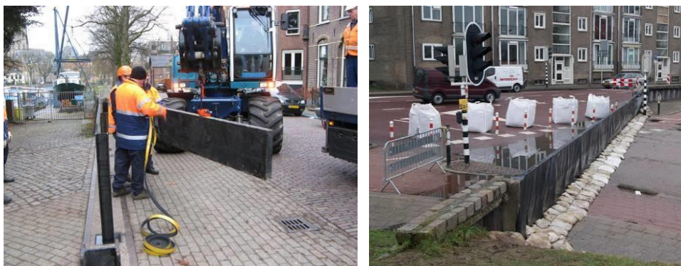
Figuur 4 Sluiting van coupures Vispoorthaven (links) en Brugstraat (rechts) te Zutphen tijdens hoogwater januari 2011 (bron: [Ref. 1])
