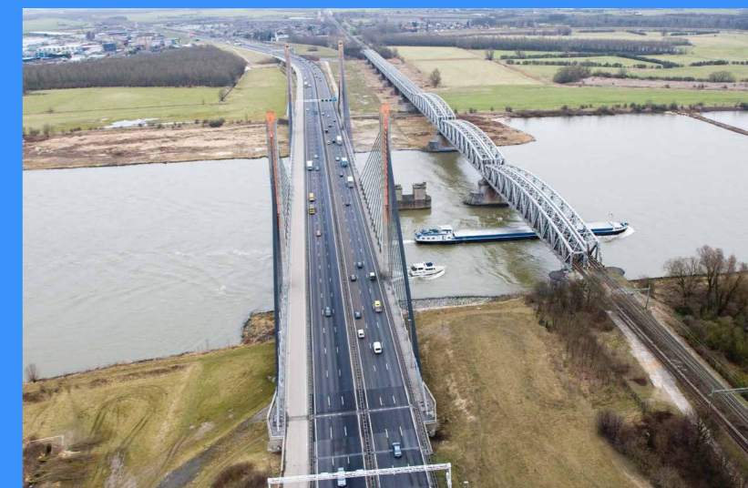
Luchtfoto van de aansluiting van de A2 en de spoorbrug op de waterkering.
