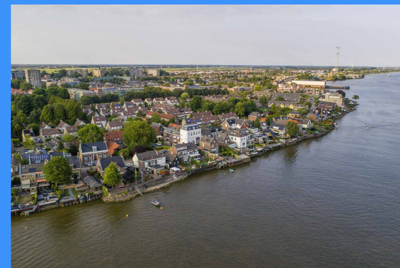
Hoogtepogave bij de rivierdijken in Sliedrecht. Een versterking van Rivierdijk-West is moeilijk inpasbaar binnen het huidige dijkprofiel [068] .
