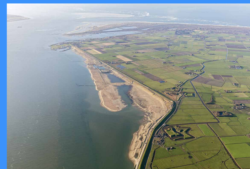
De Prins Hendrikzanddijk in aanbouw.
