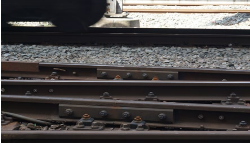
Afbeelding 10.1 ES-lassen in het spoor
