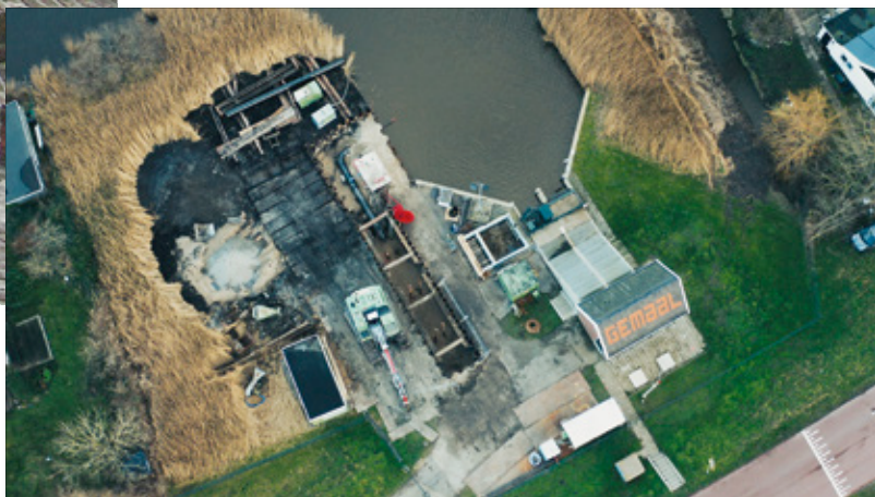
Luchtfoto van de aanleg van de vispassage Nauerna (foto: HHNK)
