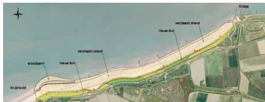
Figuur 8: Zandige versterking Nieuwvliet-Groede
