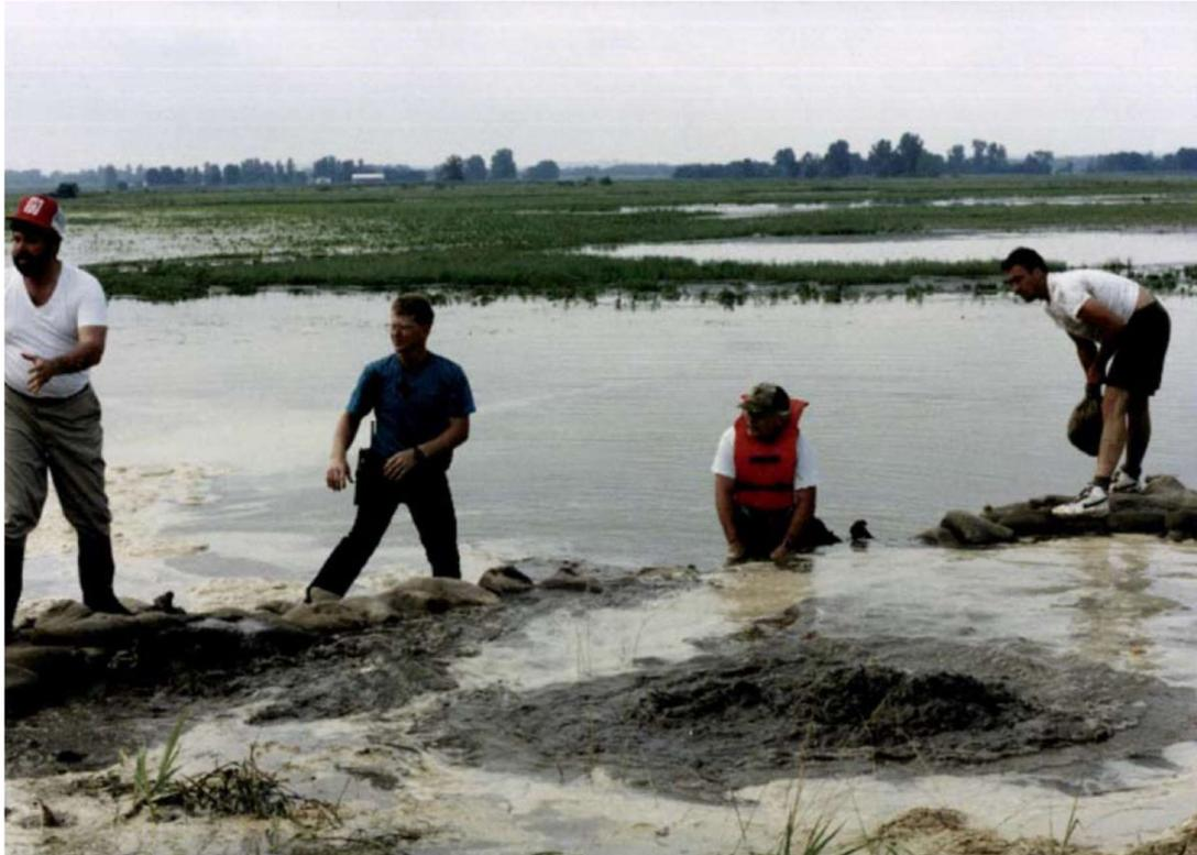
*Figuur 2.10 Tevergeefse poging om de zandmeevoerende wel bij Kaskaskia Island op te kisten: de dijk bezweek enkele minuten later (Navin, 2016)*
