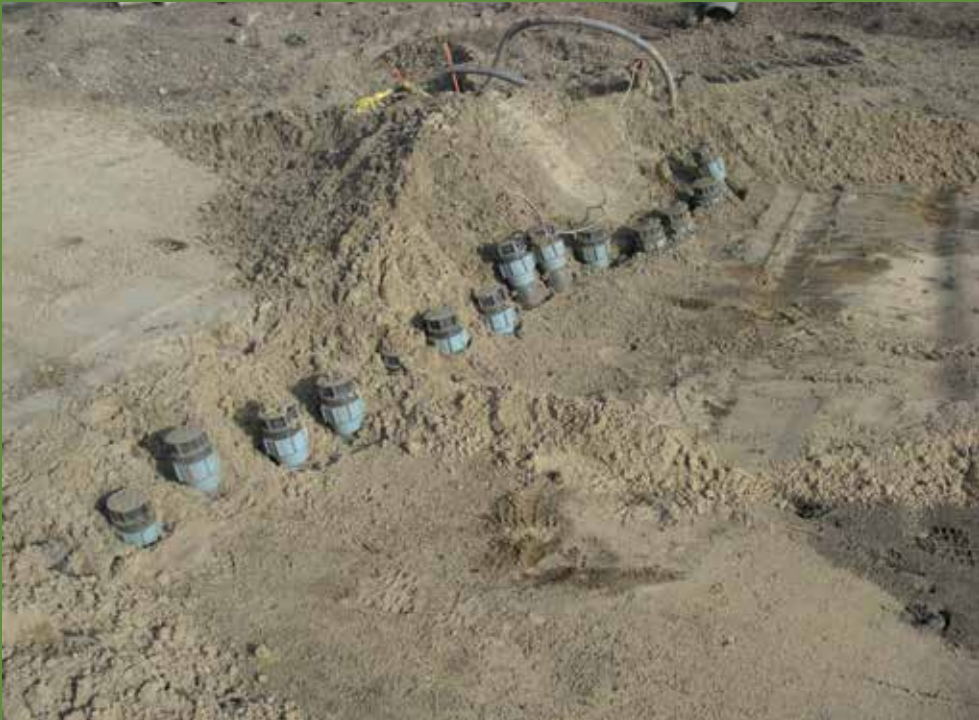
Afb. 1.2 Filters ten behoeve van bodemsanering.
