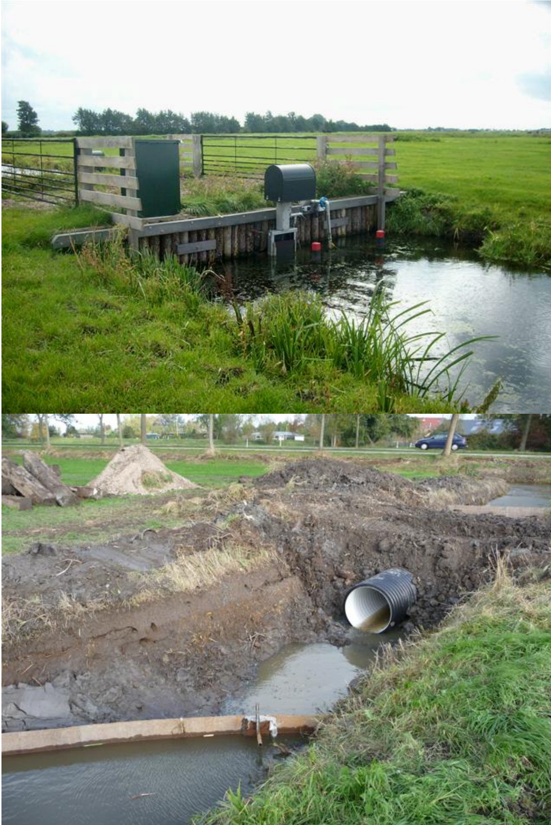
Figuur 19: Ecosluis (boven) en ecoduiker (onder). Bron: Nicolaas van Everdingen, Watermaatwerk.nl)
