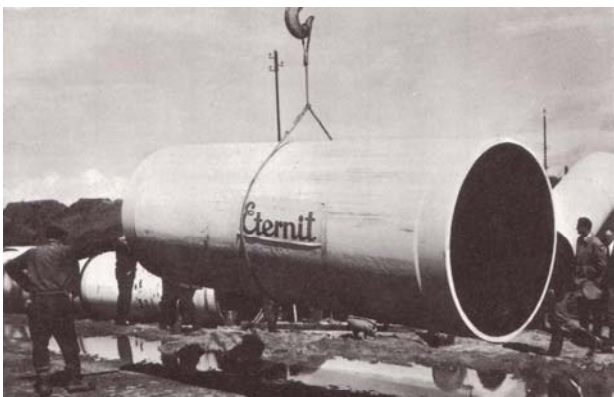
Figuur 17: Leggen rioolbuizen en drinkwaterleiding asbestcement
