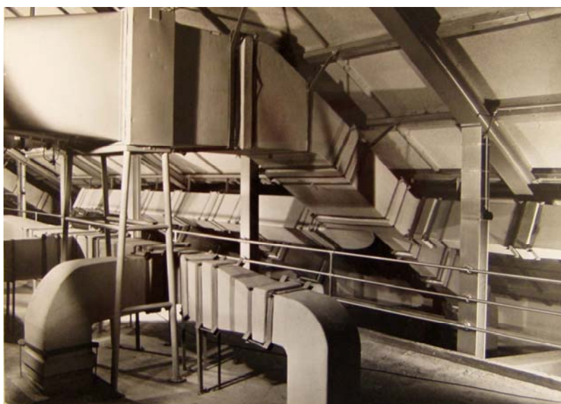
Figuur 18: Ventilatiekanalen en wandbekleding van asbestcement
