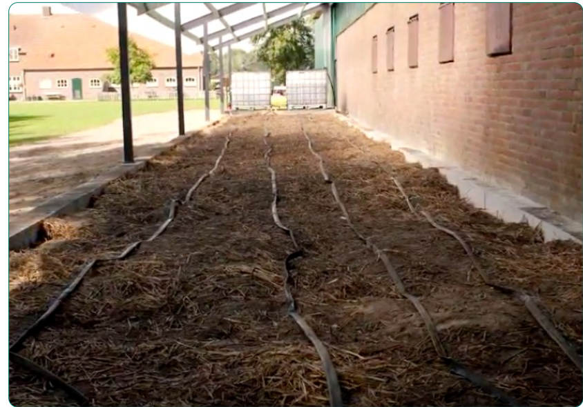
Een betonnen fytobak voor meer capaciteit.
