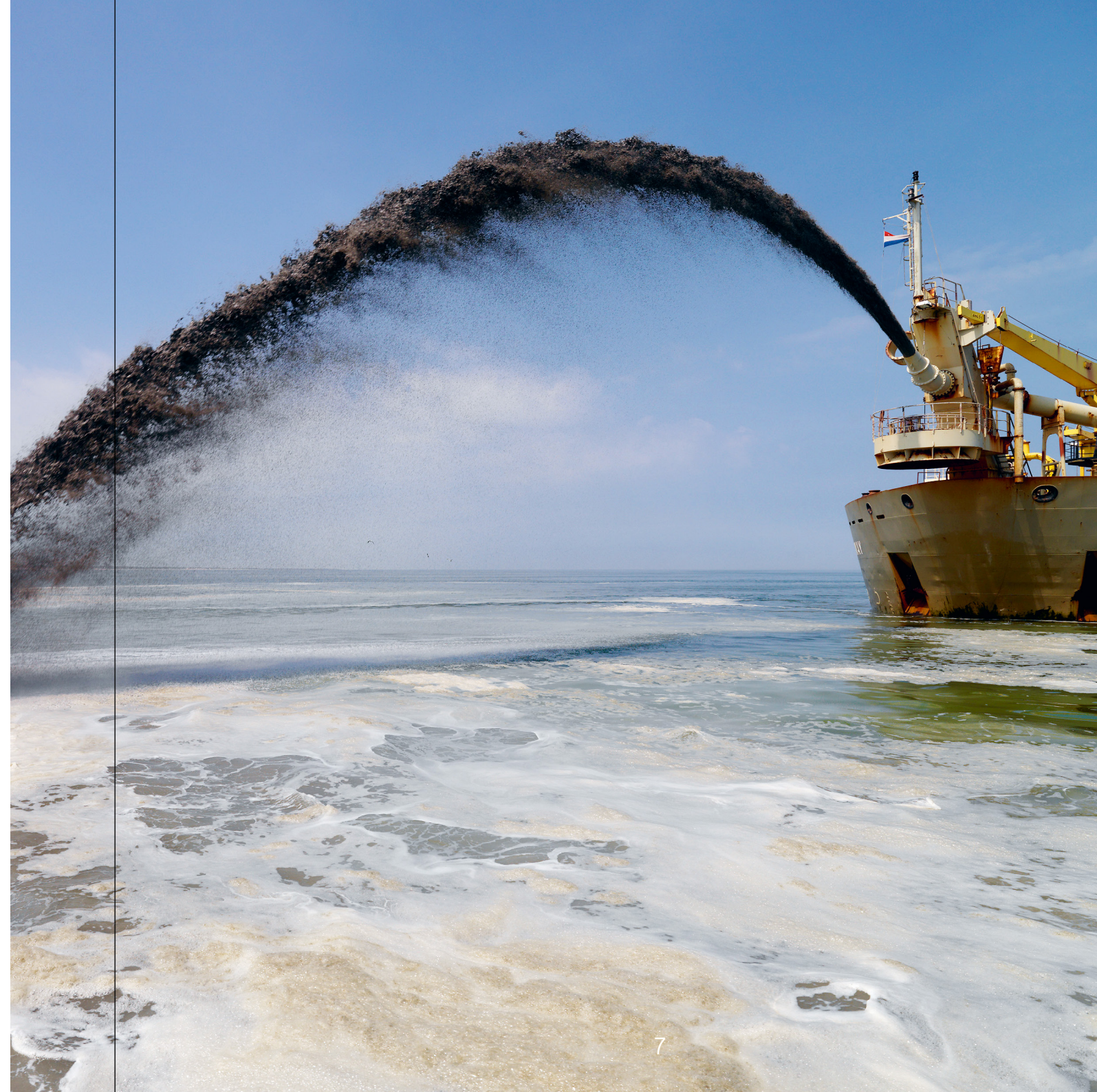
Zandsuppleties in de Noordzee ten noorden van Ameland. Een sleeopperzuiger verzamelt zand van de zeebodem ver op zee, transporteert dit naar de kust en verspreidt het vervolgens met de 'rainbowing'-techniek dichtbij de kustlijn.
