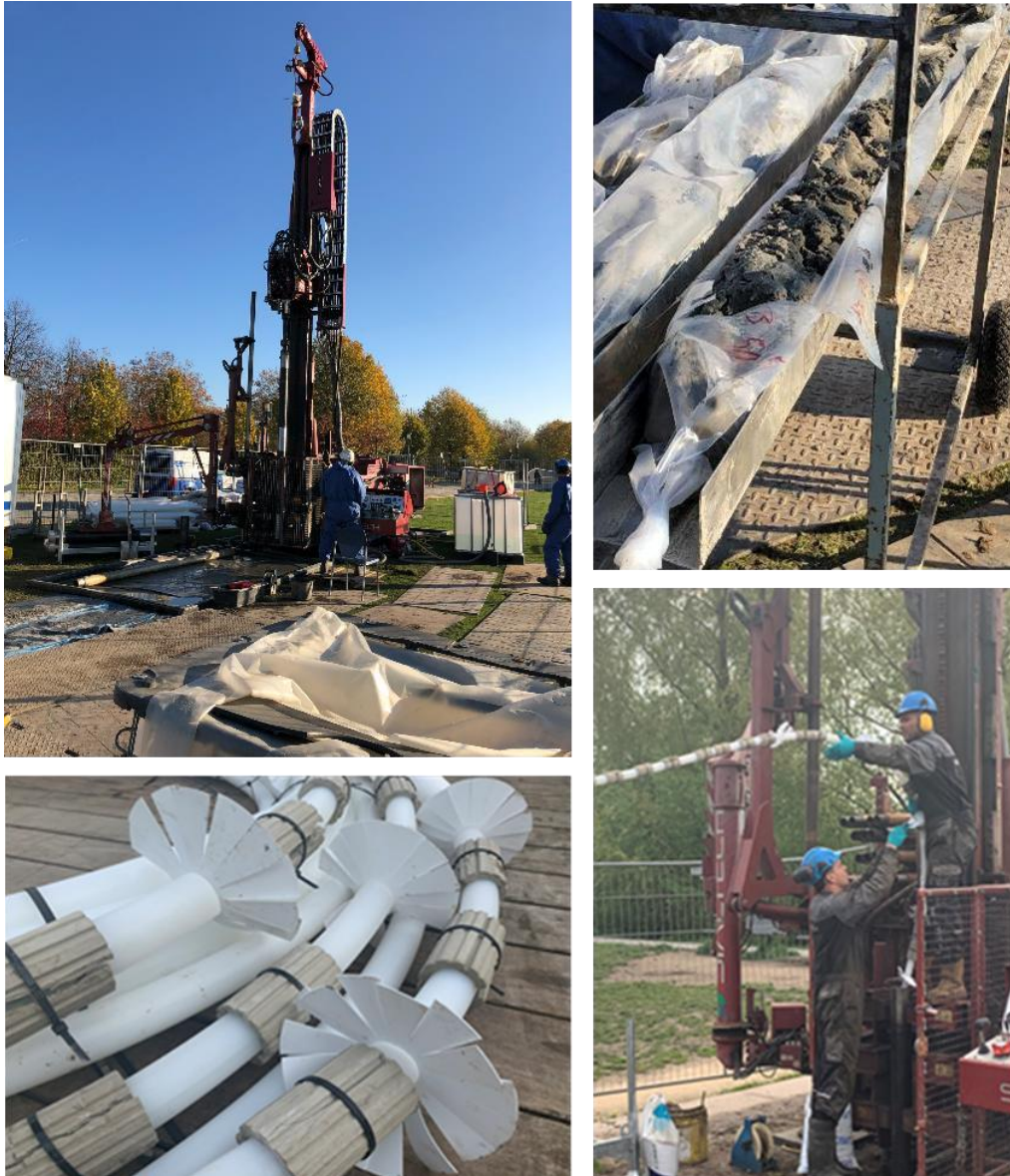
Figuur 11. Sonische boring in het Griftpark (linksboven) voor het bepalen van de bodemopbouw (rechts boven), het bemonsteren van grond, en het ontwerpen (linksonder) en plaatsen (rechtsonder) van multi level samplers
