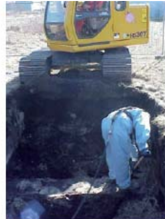
Proefleuf op GEB-terrein: voorbereidend onderzoek met maximale bevellingmaatregelen voor de veldwerkers.
