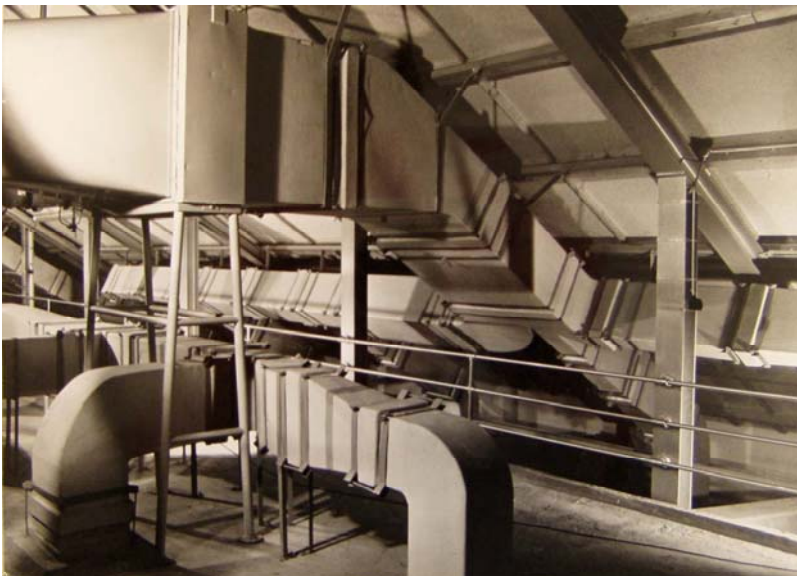
Figuur 18: Ventilatiekanalen en wandbekleding van asbestcement
