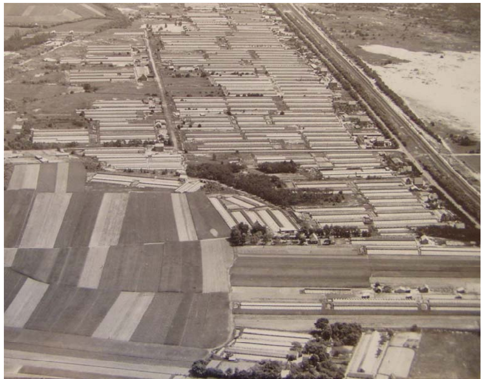
Figuur 16: Luchtfoto eendenhouderijen Harderwijk
