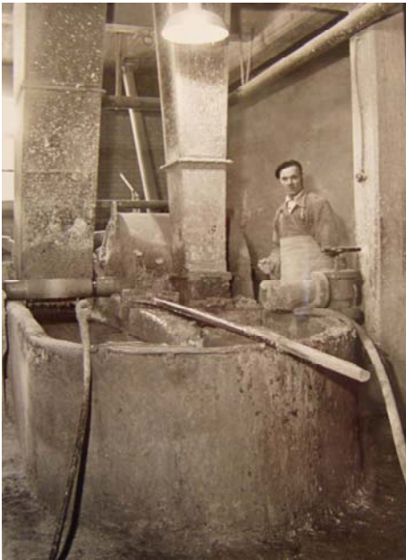
Figuur 9: Een Hollander en een buizenmachine bij Asbestona
