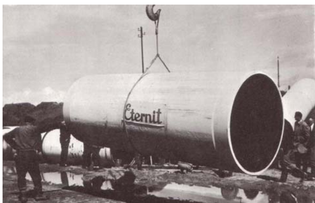
Figuur 17: Leggen rioolbuizen en drinkwaterleiding asbestcement
