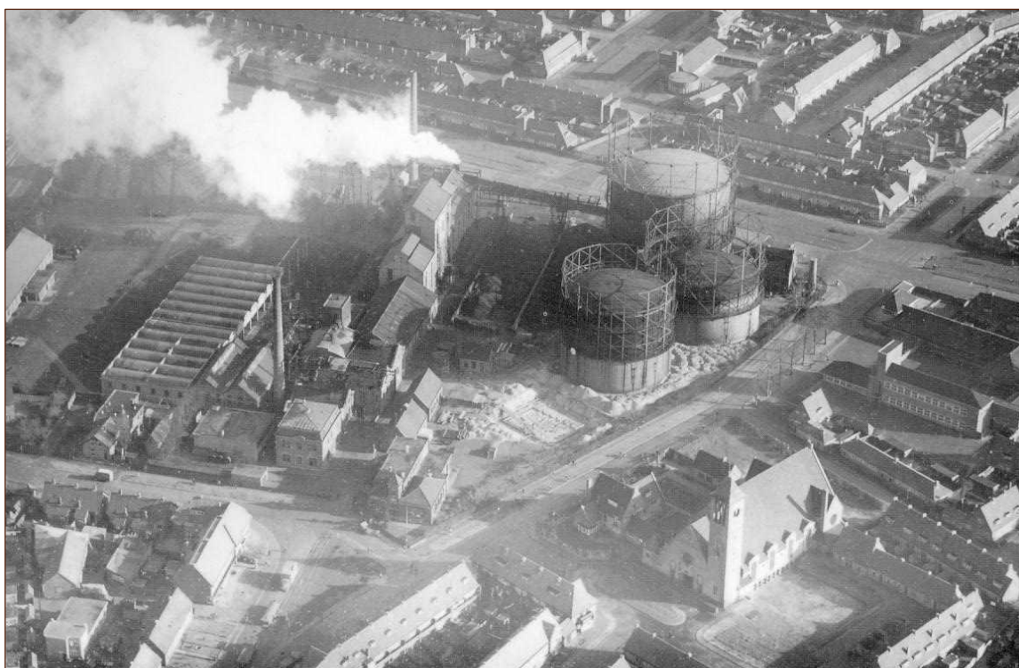
Figuur 1.1 Gasfabriek Haarlem. Bodemverontreiniging is de keerzijde van de enorme industriële ontwikkeling die Nederland heeft doorgemaakt.
